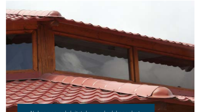
Nokpan en noksluitstuk voor de dakpanplaat.
