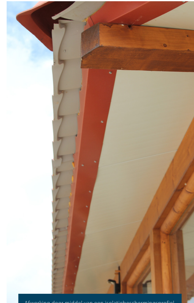
Afwerking door middel van een isolatiebeschermingsprofiel.
