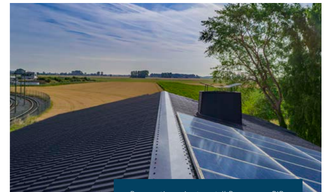
Renovatieproject met JI Permapan PIR.
